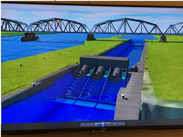
Beneden: een impressie van de sluis met drie archimedes-schroeven voor energieopwekking.
